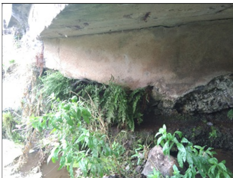
Poruchy v lici levobřežní opěry
