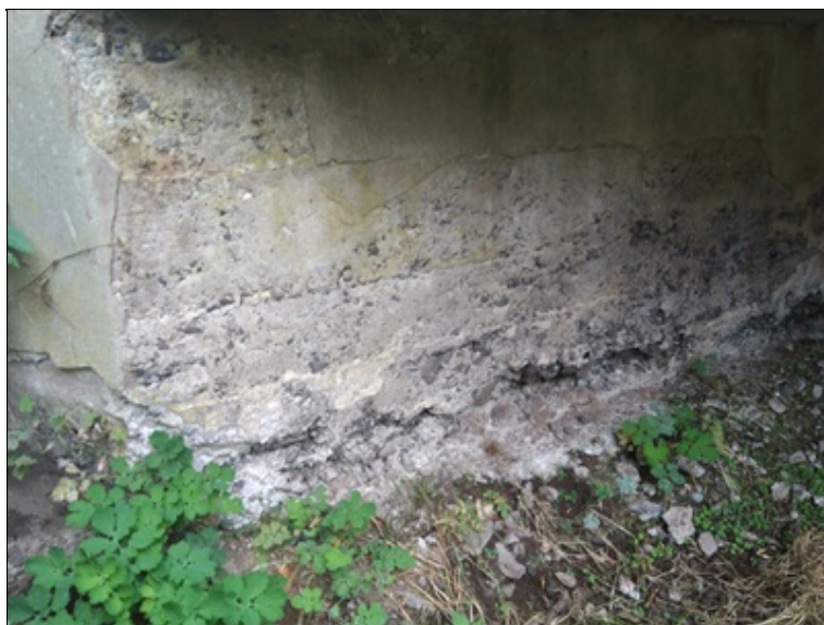
Poruchy v lici pravobřežní opěry
