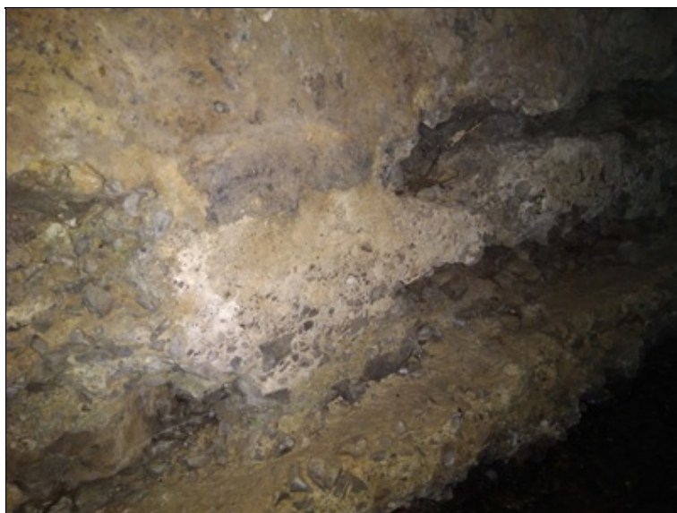
Poruchy v lici levobřežní opěry
